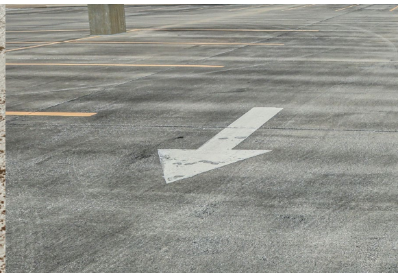
Verkehrs- und Parkflächenbau
